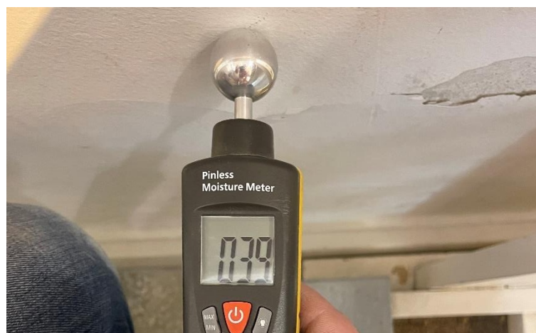
Matavimo reikšmės Pav. Nr. 8 Šiaurės vakarų sienos kampas, h – 0,3 m.
